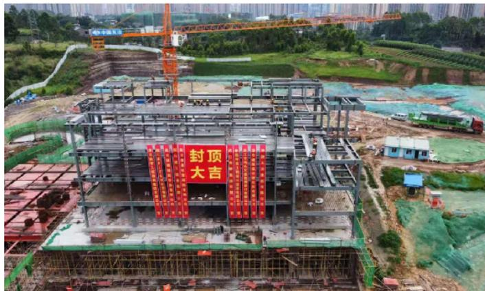
天一个样，这主要得益于钢结构装配式建筑的独特优势——建设速度快、质量优。钢构件在工厂标准化、模块化、自动化生产，既保障了钢构件的精度和质量，也为施工现场的快速安装工作奠定了基础。
